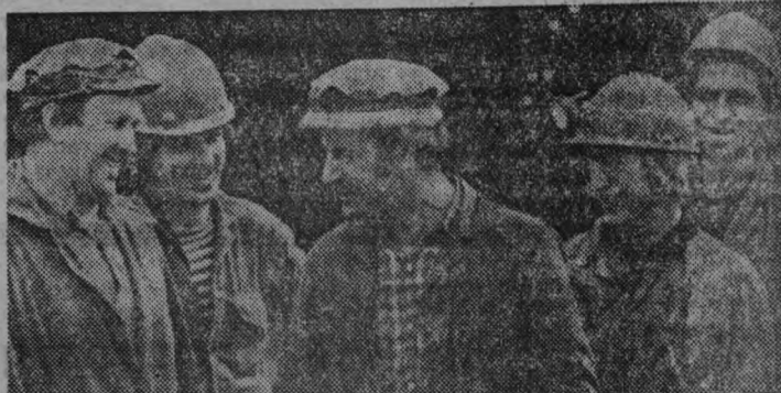
В одиннадцатой пятилетке начато сооружение четвертой ГЭС Нарынского каскада — Таш-Кумырской. Бригаду проходчиков, работающую на проходке обводного тоннеля, возглавляет опытный строитель коммунист Ф. Абакумев.
