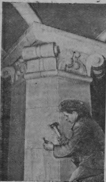
Строительство 4-й очереди Московского метрополитена. Мраморщик А. Захаров за отделкой колонны на станции «Комсомольская».
