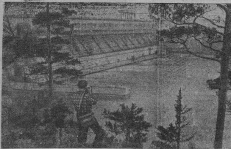
Вид крупнейшей в мире Братской ГЭС.
