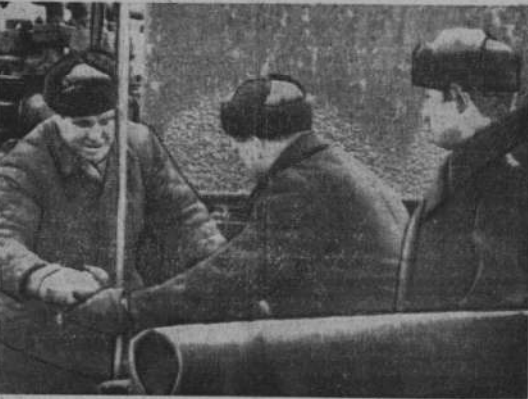
Идет подготовка к переводу эксплуатации скважины № 252 на электропогружной насос. НА СНИМКЕ: операторы Камил Касымов и Афаулла Юнусов за креплением подвешенного фланца. Справа — геолог участка В. Н. Курапов.
