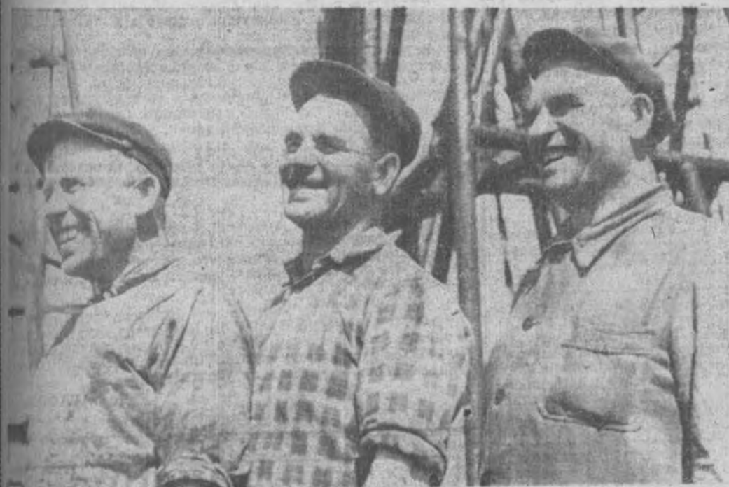
Участок № 2 первого промысла НПУ «Бугурусланнефть». 18 мая здесь начался перевод скважины № 161 на электропогружную установку, а 21 мая нефтяники уже завершили эту работу.
