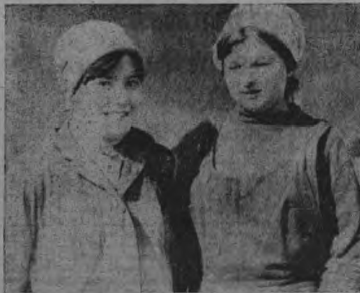
НА СНИМКЕ: комсомолки Любовь Кузнецова и Мария Пензина. Они строители-отделочники, трудятся в бригаде А. Н. Саблиной. Добросовестно работают девчата, по-комсомольски.
