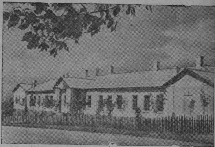
Узбекская ССР. Для детей нефтяников промысла «Южный Аляш» треста «Калининнефть» построена новая средняя школа. НА СНИМКЕ: новая школа в поселке нефтяников. Фото С. Безносова. Прессклише ТАСС.
