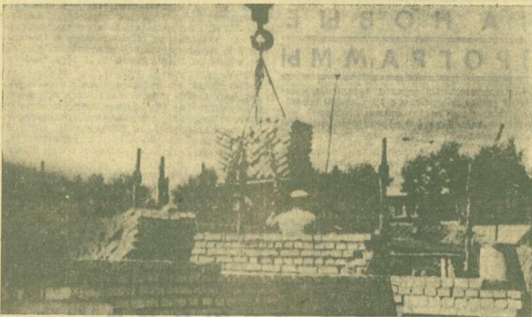
НА СНИМКЕ: НА УГЛУ УЛИЦ КОМУНИСТИЧЕСКОЙ И КРАСНОГВАРДЕЙСКОЙ РАЗВЕРНУЛОСЬ СТРОИТЕЛЬСТВО МНОГОКВАРТИРНОГО ДОМА.
